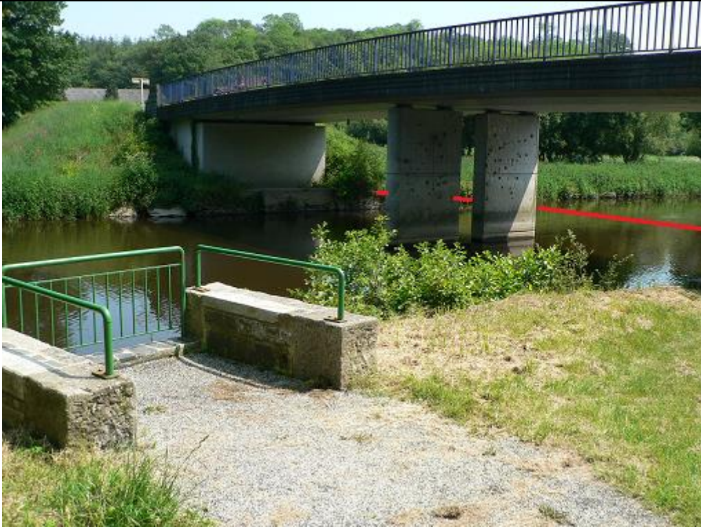
Du pont de la station vers l'aval Vanne fermée et ouverte
