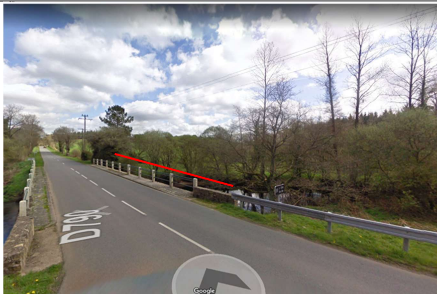
Pont de la D790 (Pont Blanc - direction Plouray) Tyrolienne ou depuis le haut du pont : section aval
