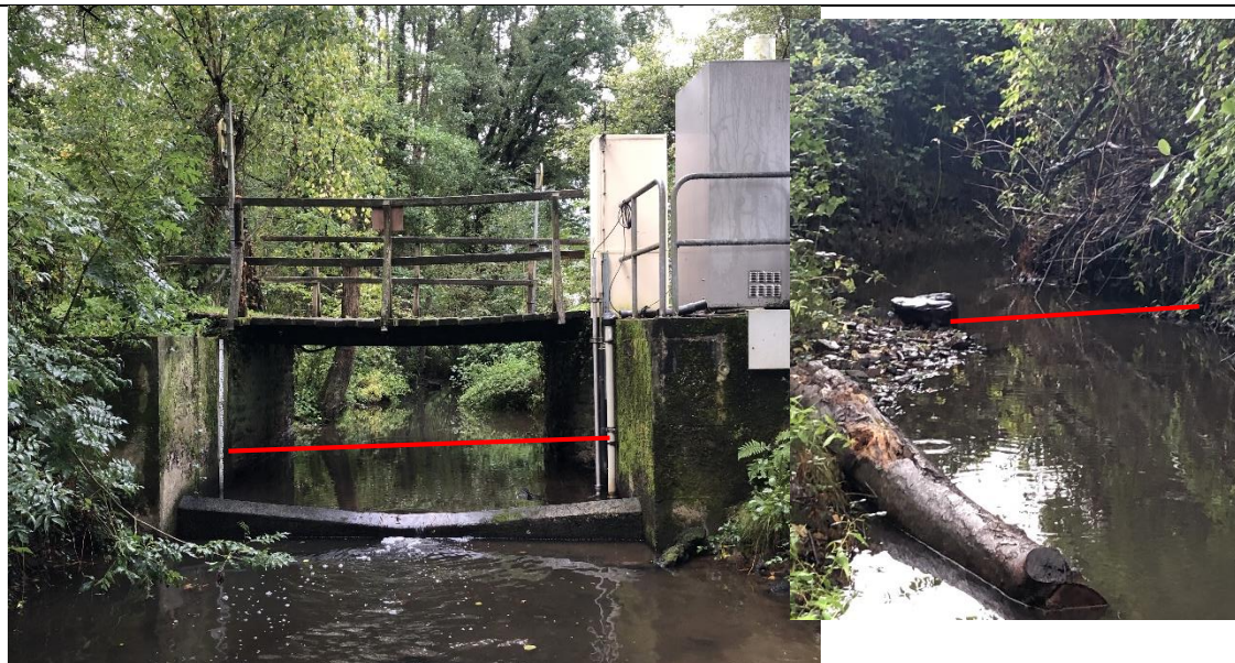
- Sous le pont au droit de l'échelle OU 20m aval station en très basses eaux.
