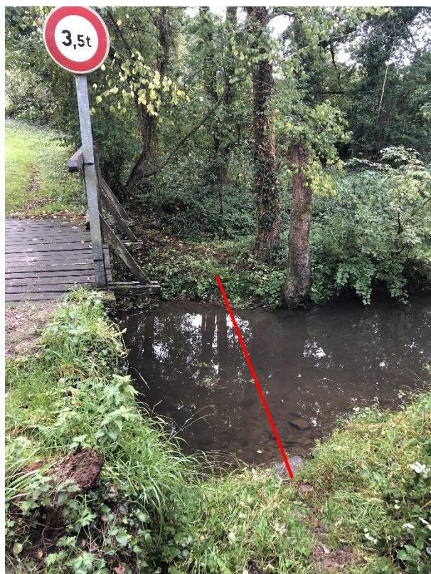
- En tyrolienne en aval de la passerelle
